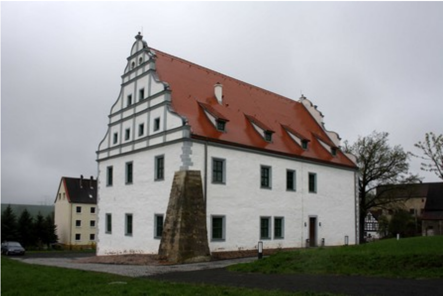
Herrenhaus Oberzetscha bei Altenburg, beispielhaft restauriert und vor dem Verfall gerettet durch die Stadt Altenburg
